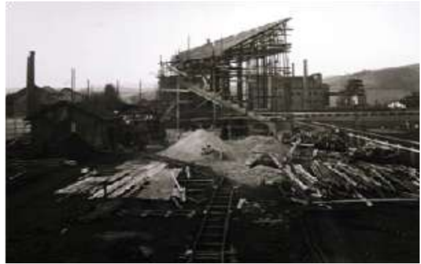
Construction du Stade Geoffroy-Guichard
